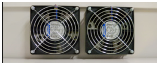
Temperaturstyrd fläktsystem
