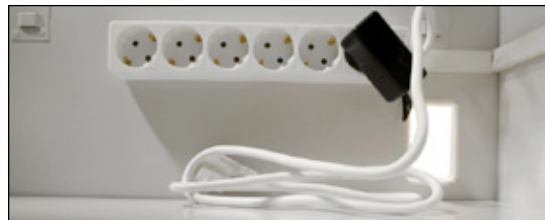
Grenuttag 230 Volt och hål för kabelgenomföring
