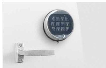
Huvuddörren utrustad med högsäkerhetslås samt med ett elektroniskt kodlås
